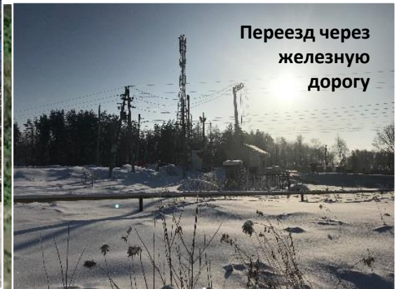
Направление ж/д полотна на Москву
