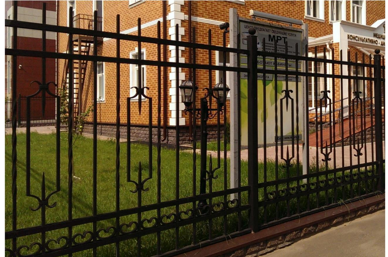
Элементы ограждения между столбами секции могут отличаться дизайном, сохраняя габаритные размеры секции и шаг элементов между столбами.
