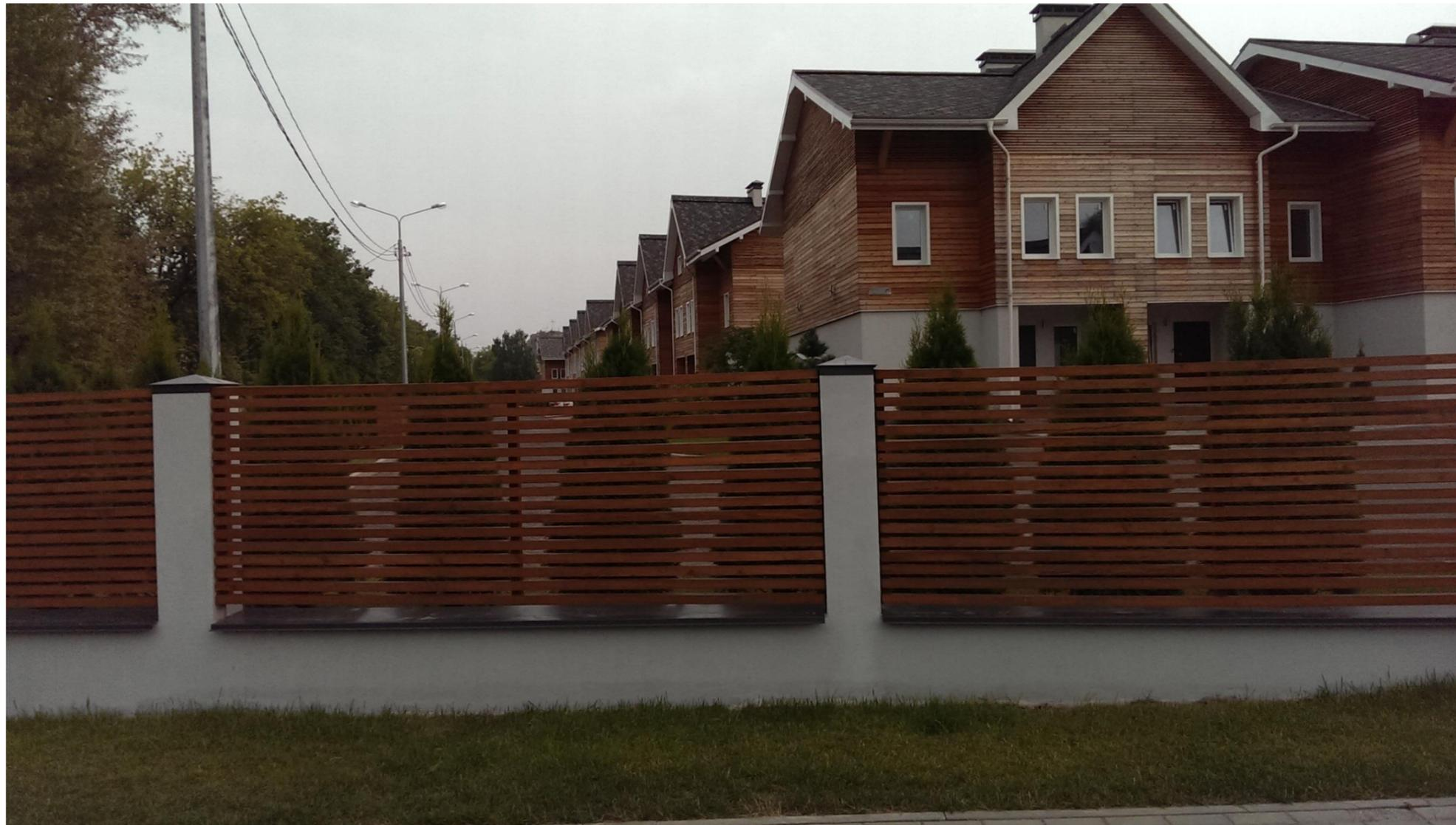
Элементы ограждения между столбами секции могут отличаться дизайном, сохраняя габаритные размеры секции и шаг элементов между столбами.
