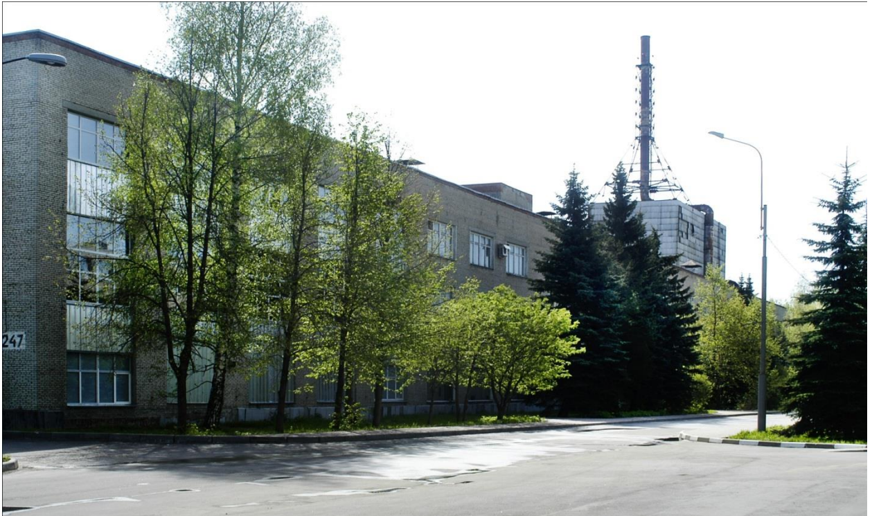
Рисунок 2.3.2 - Корпус 247 «Комплекс критических стенов»
