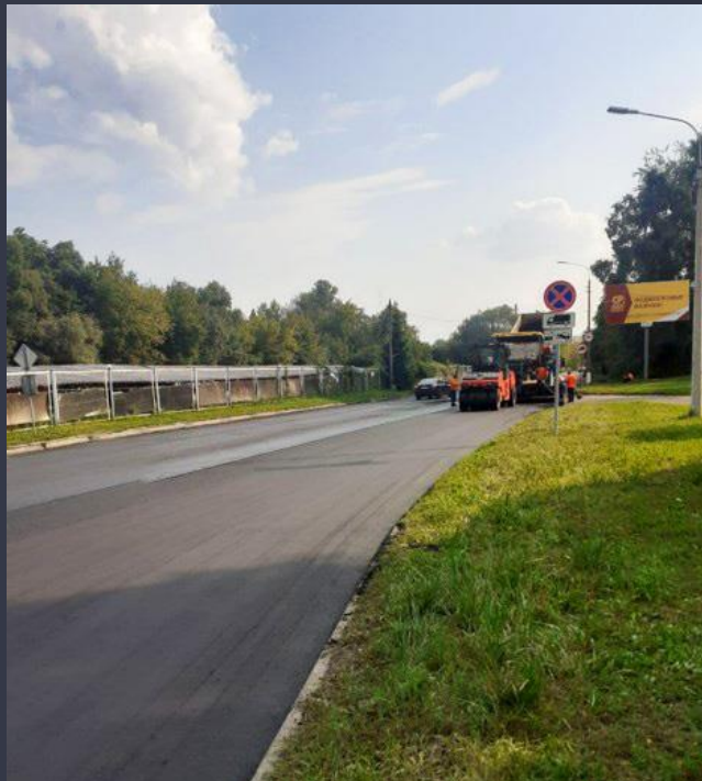
Ремонт дороги на пр. Южном
