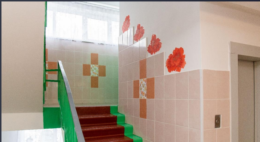
Ремонт подъезда в д. 9 по пр. Ленина сделали жители
