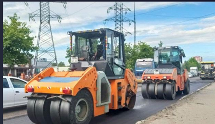
Ремонт дороги на ул. Жулябина
